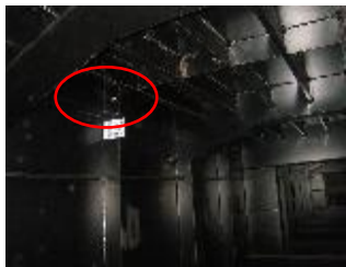
写真-3 垂直補剛材(補強リブ)
