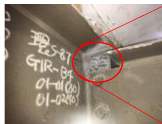
写真-2 垂直補剛材 (タイプ1, 2, 3)
