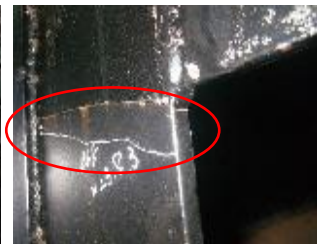
写真-3 垂直補剛材(補強リブ)
