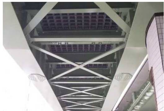
写真-1 信濃橋入路(ワッフル型UFC床版)
