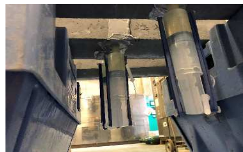
写真-3 自動式低圧注入工法
