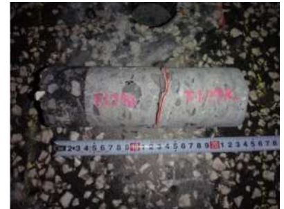
写真-1 内部の水平ひび割れ
