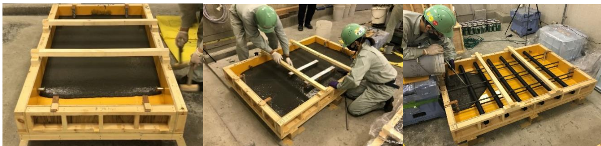
写真-1 テスト床版作製状況（左：ひび割れ床版，中：浮き床版，右：PC 鋼材破断床版）
