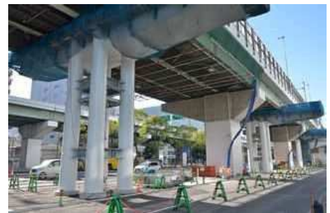
写真-1 鋼管集成橋脚 (西船場 JCT)
