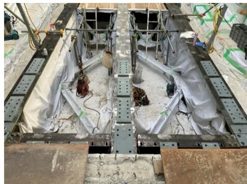
(b) 高力ボルト孔の削孔
