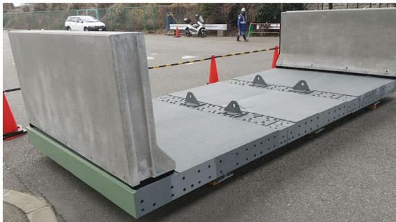
写真-3 正曲げ区間の架設ブロック
