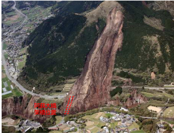
図-1 阿蘇大橋周辺斜面の被害状況（2016年熊本地震） 1)
