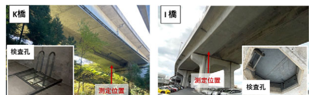
写真-1 対象橋梁外観（左：K 橋，右：I 橋）
